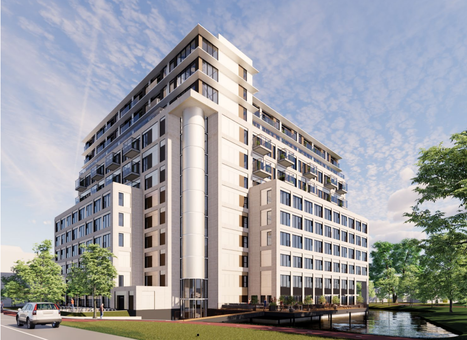
Transformatie en optopping Jacobs pand, Leiden Bestaande constructie hergebruikt en uitgebreid met 3 lagen
