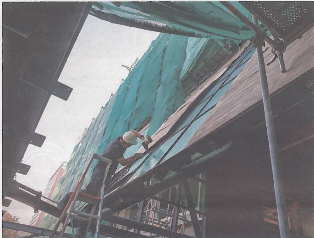
In ongeveer acht maanden tijd krijgt het Rabokantoor van zes bouwlagen een nieuwe buitenschil. Foto: Dolph Cantrijn
