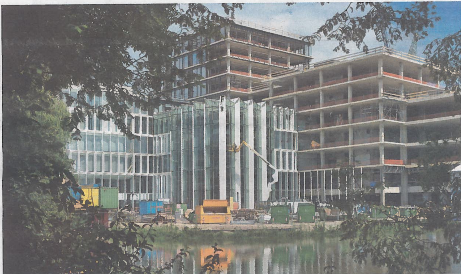
Leegstaand vastgoed heeft betere kansen bij herbesteding nadat het energiezuinig is gemaakt. Op de foto het Amex-complex in Utrecht dat is gestript en vervolgens opnieuw opgebouwd. Vermindering van het energieverbruik speelt daarbij een hoofdrol. Foto: Ton Borsboom
