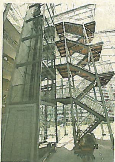
▲ Het atrium onder het glazen dak heeft een open trap.
