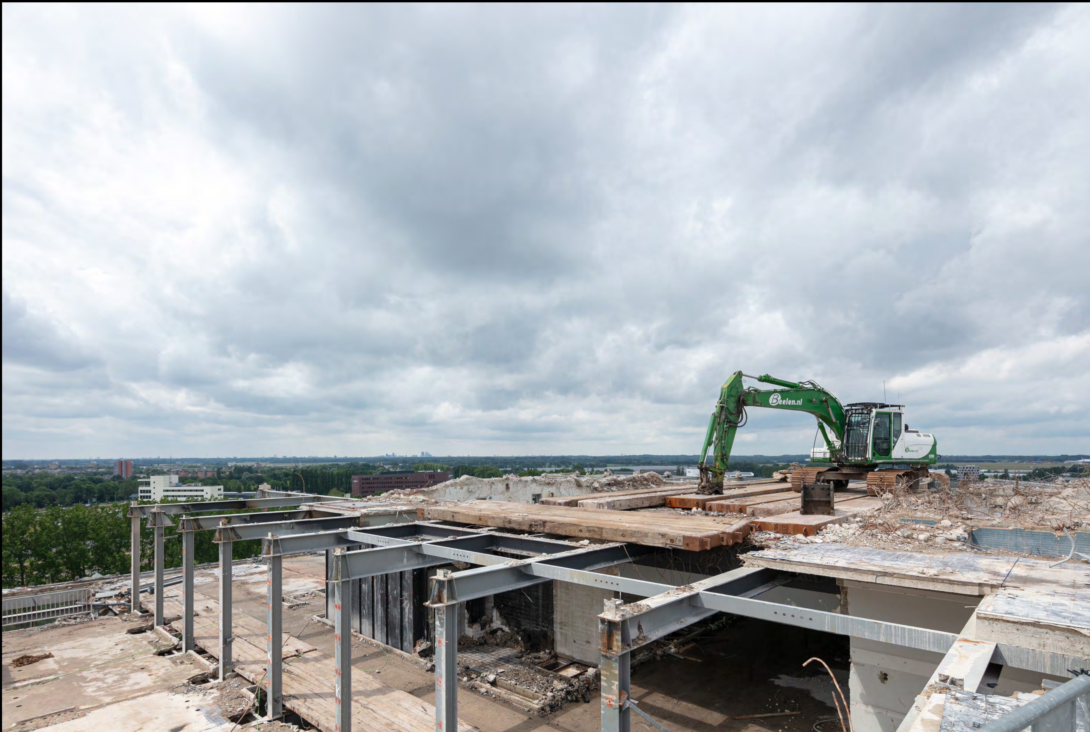
Losmaken bestaande betonvloer, Gorlaeus hoogbouw, Leiden, 2019
