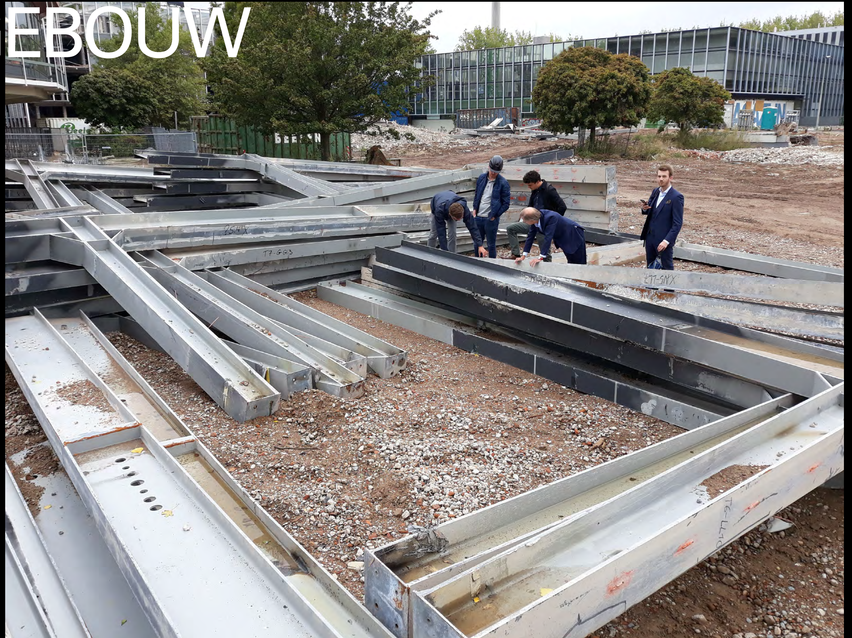
Geogste staalconstructie, Gorlaeus gebouw, Leiden, 2019
